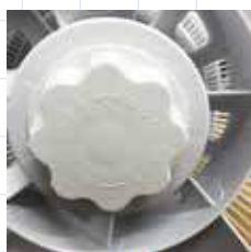
換気扇の切込み部分 凹凸を合わせないと取付ができません。
