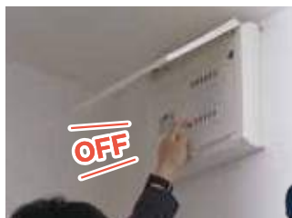
2 | 浴室乾燥機の安全ブレーカーを切る。
